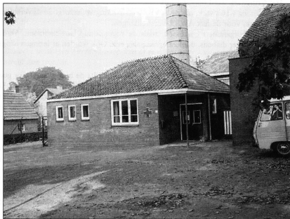
Het Groene-Kruisgebouw naast de voormalige zuivelfabriek. Het is zoals de zuivelfabriek destijds ook afgebroken
